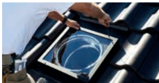
Montaż od strony dachu zapewnia wyjmowane skrzydło
