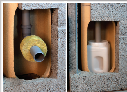
2 Możliwe sposoby odprowadzenia kondensatu: do kanalizacji lub do zbiornika kondensatu
